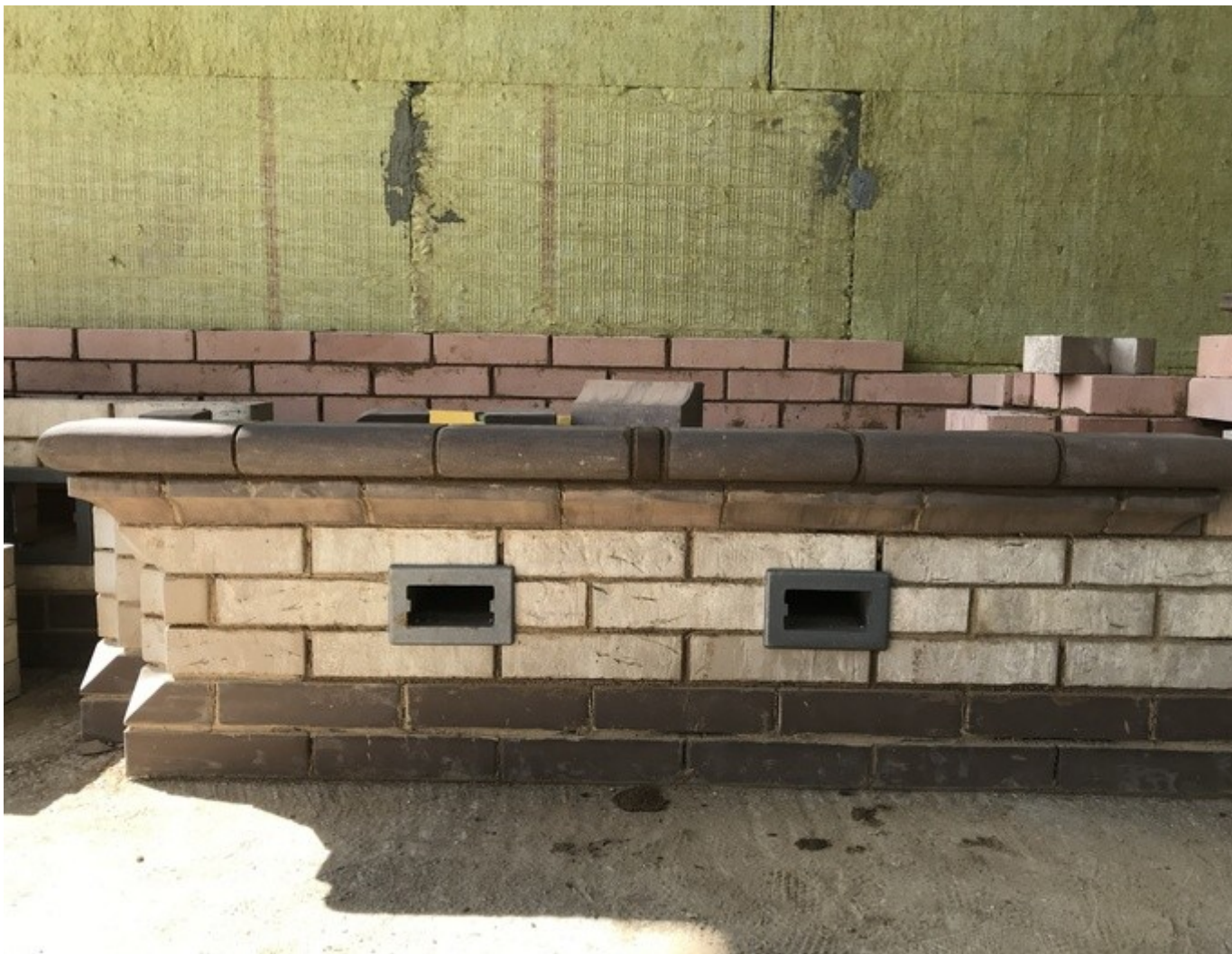
На 6 ряду устанавливаем колосник и выкладываем кирпич резаный под 45 градусов
