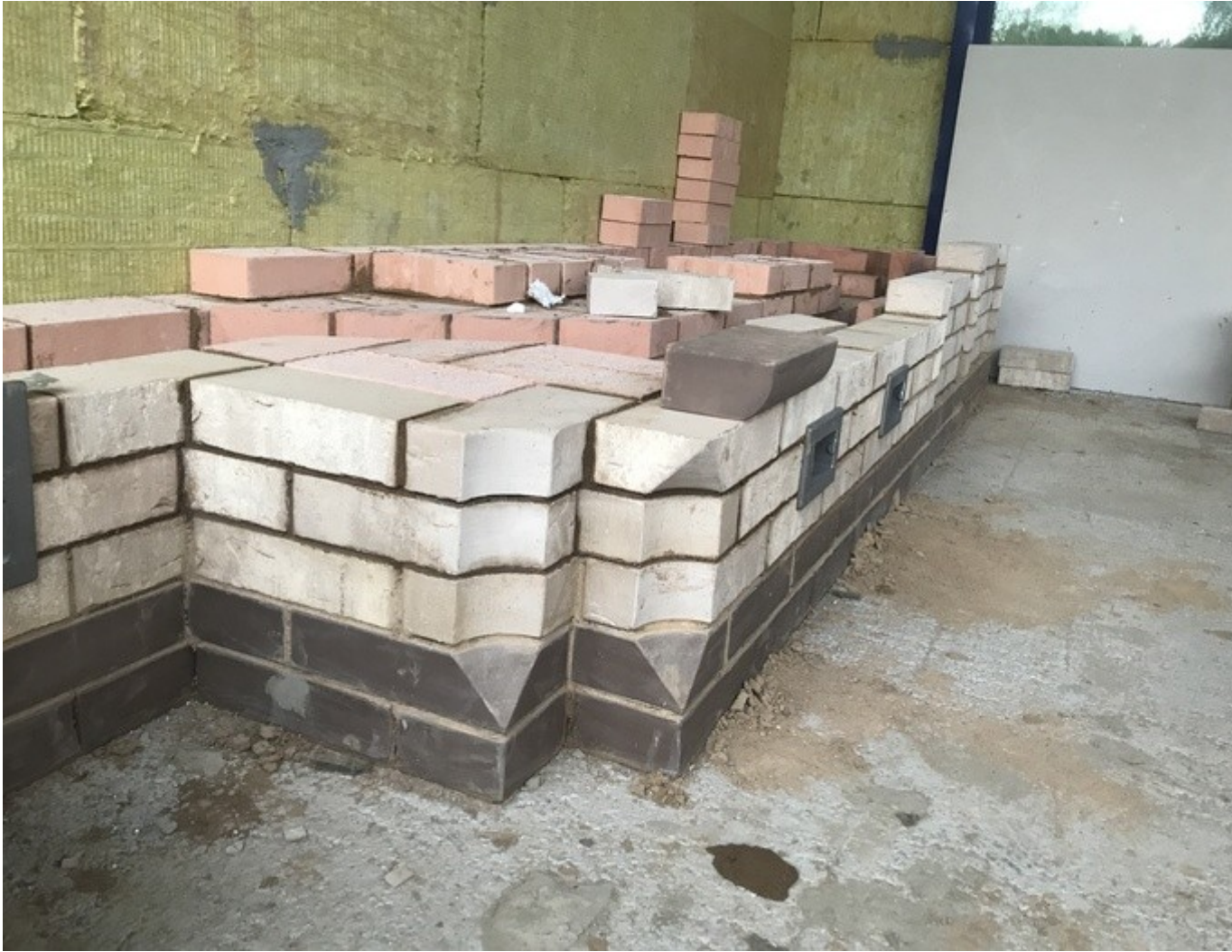
На 5 и 6 ряду по контуру мангала выкладываем фигурный кирпич (на объекте дополнительный нижний ряд)
